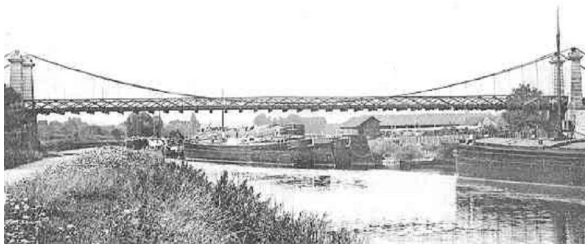
L'ancien pont du Bac à l'Aumône, construit vers 1850 (carte postale de 1919)
