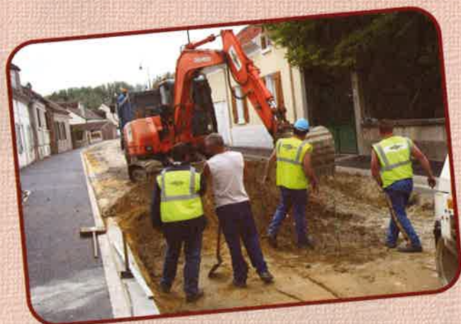
Travaux dans la rue du tour de ville
