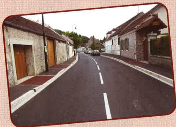
La réfection de la rue Saint-Simon.
