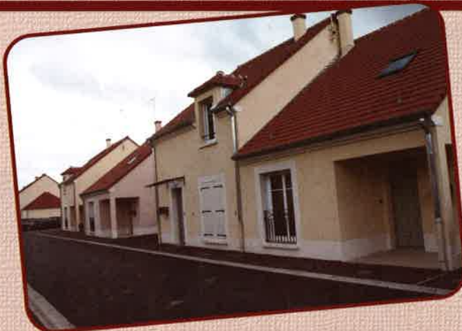
La réalisation des maisons pour personnes âgées, impasse J. Bourin.
