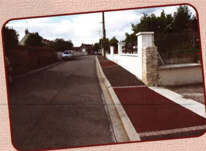
La réfection des trottoirs de la rue du Tour de ville.
