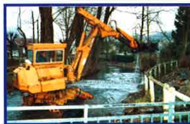
Travaux sur l'Aronde
